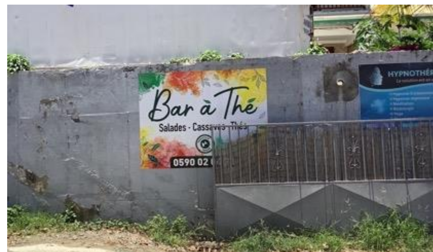
Préenseignes sur clôture aveugle, Capesterre-Belle-Eau, mai 2022
