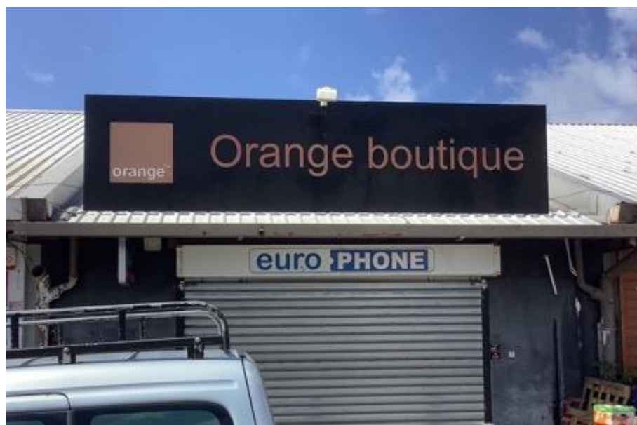
Enseigne sur toiture avec un panneau plein - illégale, Capesterre-Belle-Eau, mai 2022
