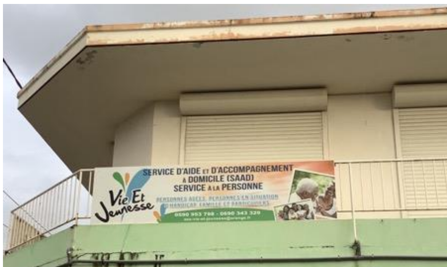
Enseigne parallèle au mur sur un balcon, Capesterre-Belle-Eau, mai 2022
